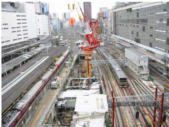
写真-2 タワークレーンでの駅改修工事
