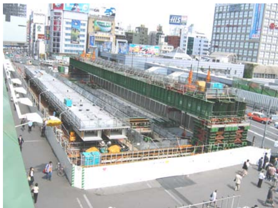
写真-3 旧橋撤去後の新橋架設状況
