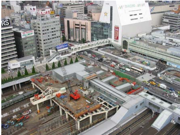
写真-1 営業線直上に張出しての基礎杭施工
