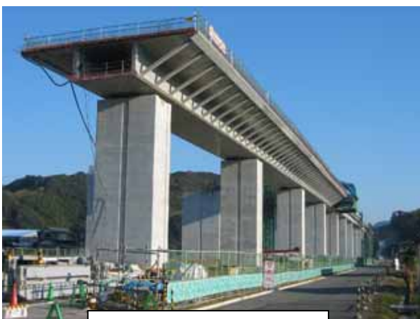
写真-3 ストラット箱桁構造
