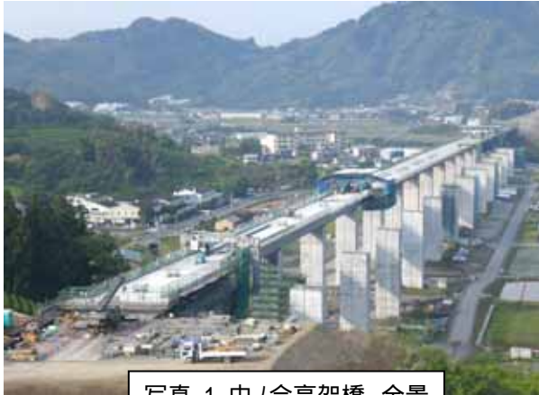
写真-1 中ノ合高架橋 全景
