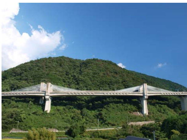
⑨ 唐櫃新橋（北区） 阪神高速北神戸線のこの橋梁は、斜張橋としては主塔が低く、六甲山の山並みの風景にとけ込んでいます。
