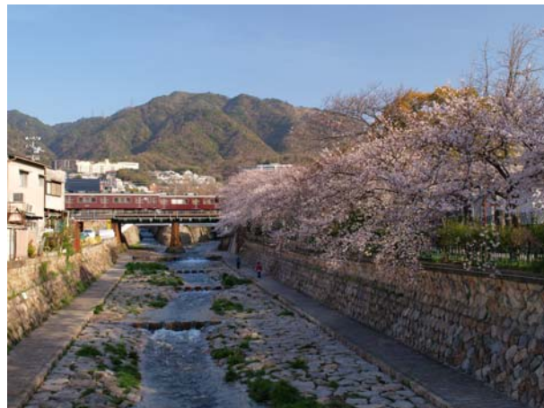
④阪急神戸線都賀川橋梁と桜（灘区）
