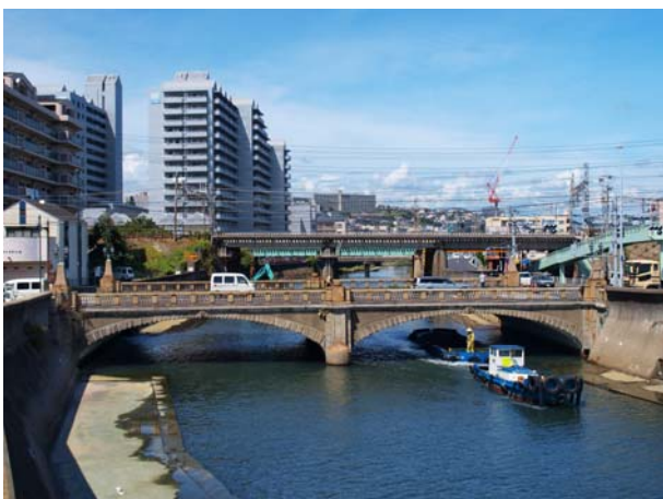
⑧ 福田橋（垂水区） 国道2号に架かる80年以上も現役の橋梁です。貼石で飾られ、石の欄干の四隅の飾柱が時代を感じさせてくれます。
