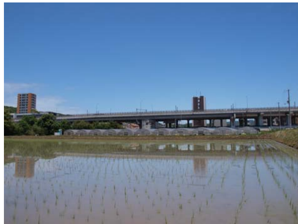
⑥ 伊川谷高架橋（西区） 西神ニュータウンと都心をつなぐ地下鉄と市道の高架橋で、田植えが終わったばかりの水田に映る姿が印象的です。
