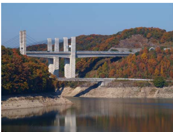
⑩衝原橋（北区） 建設当初は世界最大のエクストラドーズド PC 橋でした。紅葉の季節はつくはら湖に写る姿が一層美しくなります。
