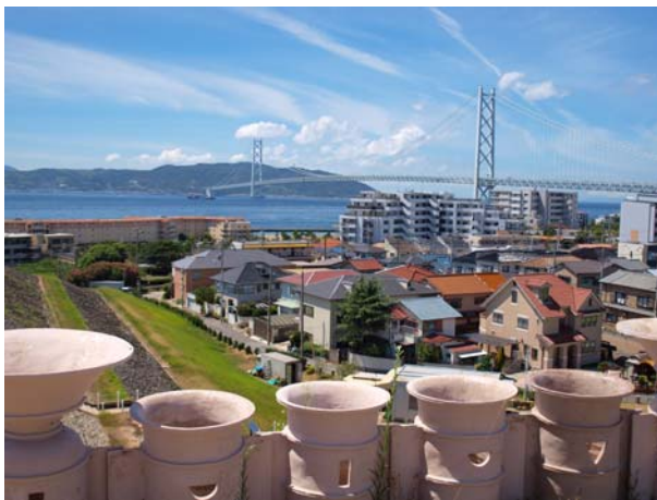
⑧明石大橋（垂水区） 世界最長の支間長を持つ吊り橋です。五色塚古墳からは全景が見渡せ、時代を超えた技術力の対比に魅せられます。
