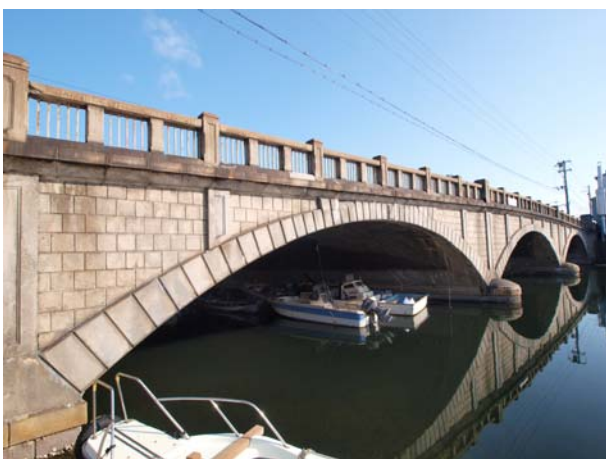
⑨大輪田橋（兵庫区） 神戸大空襲と阪神・淡路大震災を乗り越えてきた、兵庫運河にかかる石造風のコンクリートアーチ橋です。
