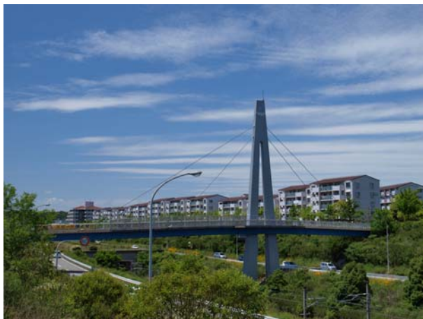
⑤ユニバーシアード記念歩道橋（西区） 大学生のオリンピックといわれるユニバーシアードが神戸で開催されたのは85年ですが、その1年前に造られた橋です。
