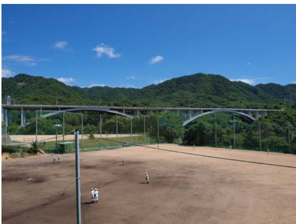
⑦水晶山橋（北区） 2 径間連続コンクリートアーチ橋としては、世界随一の規模を持つ阪神高速北神戸線の橋梁です。
