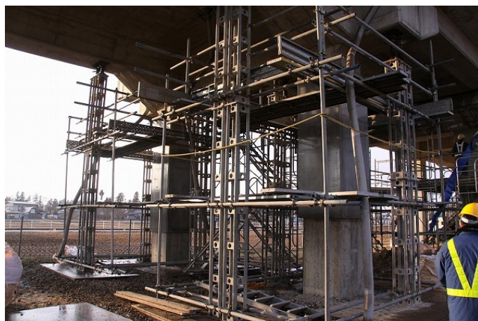
写真 1 新幹線高架橋の復旧の様子 (岩手県、2011 年 3 月)
