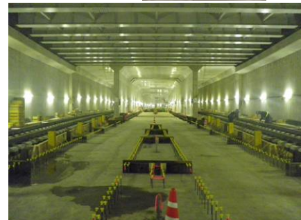
図 1 現場施工状況
