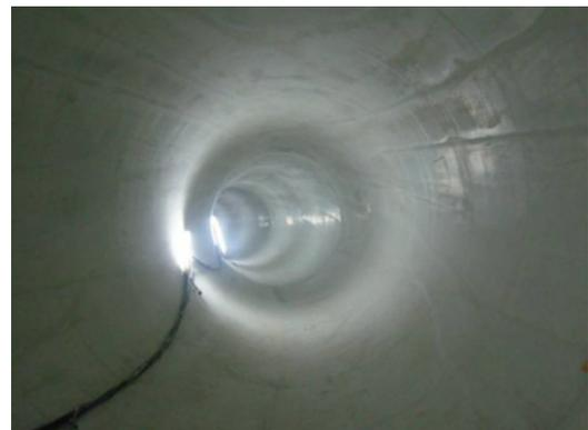
写真-3 二次覆工コンクリート仕上げ（3,750mm）
