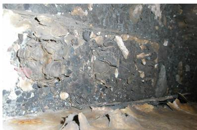
写真-2 リベットの腐食例
