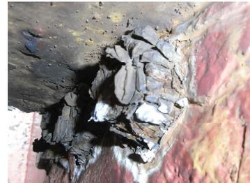
写真-3 ボルトの腐食例
