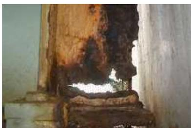
写真-1 鋼橋桁端部の腐食例
