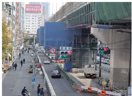
写真-1 大阪港線 梁拡幅部支保工状況
