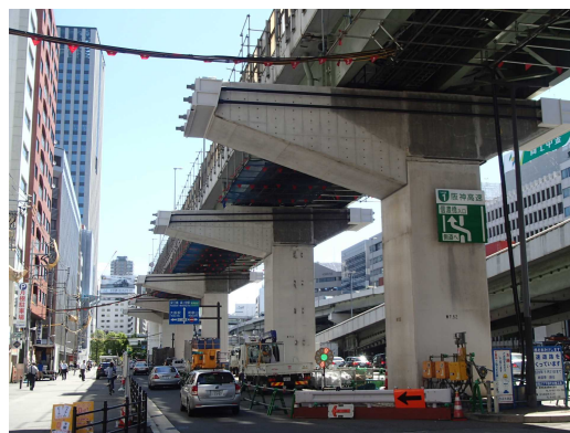
写真-2 梁拡幅完了
