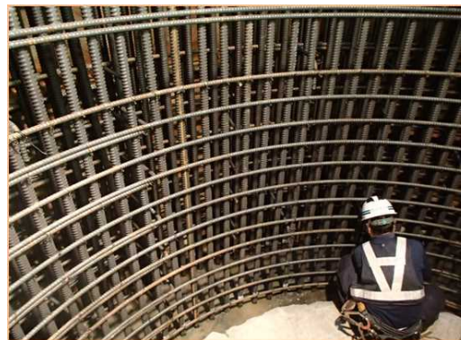
写真-3 鋼殻内での鉄筋組立状況
