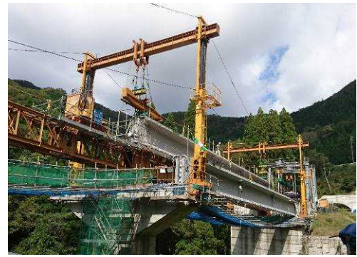
【架設作業状況】
