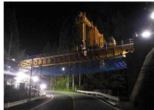
【夜間作業状況】
