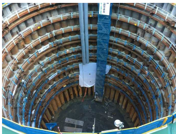
写-2 流入部の立坑内部
