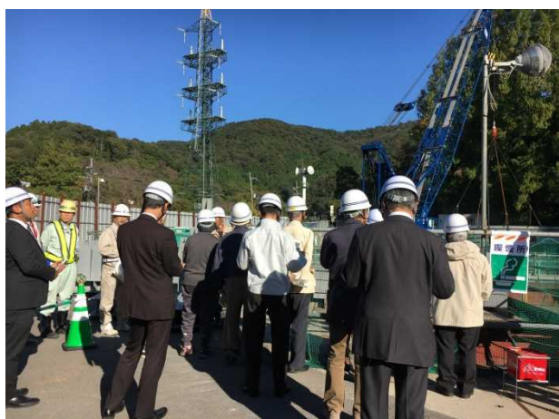
写-1 ゲート室部での概要説明
