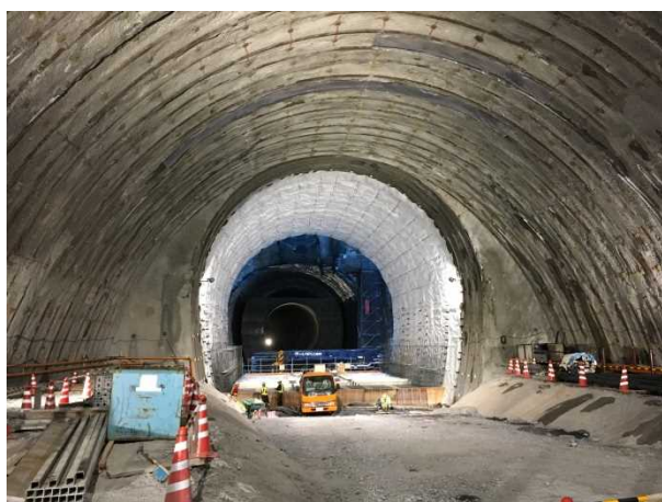
写-3 減池部トンネル内工事状況
