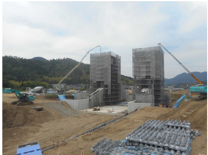
コンクリート打設状況
