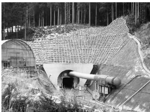
水海川導水トンネル坑口の写真
