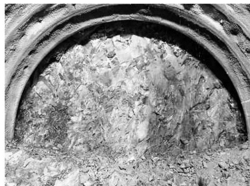
水海川導水トンネル切羽写真
