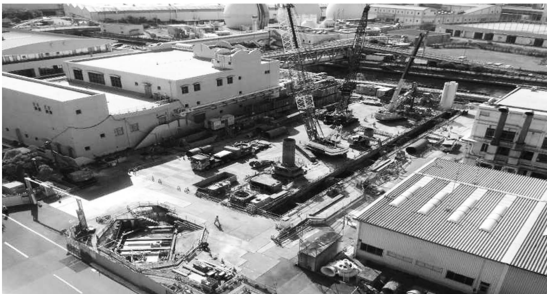
工事状況(R1.6)
