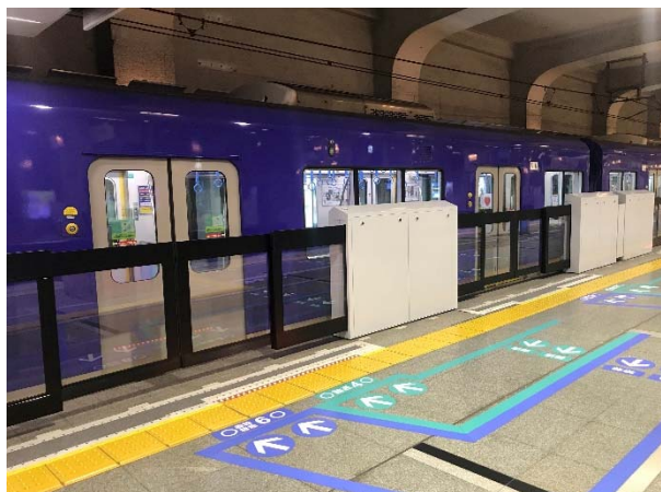
神戸三宮駅の可動式ホーム柵（工事中の様子）
