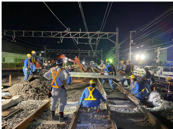
写真-6 貨物上り線の線路切換状況
