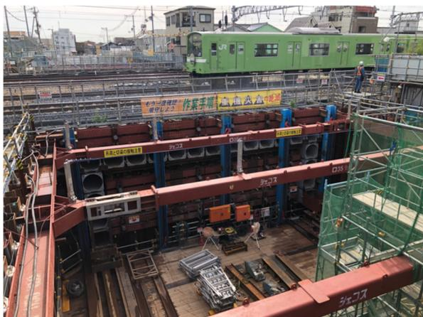
写真-3 箱型ルーフ施工状況
