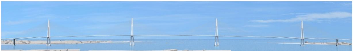
新港・灘浜航路：5径間連続斜張橋（4本主塔）、最大支間長約650m
