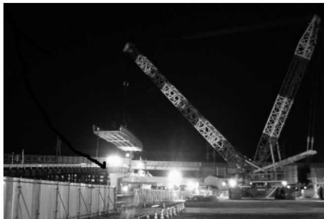
大將軍橋 橋梁の撤去
