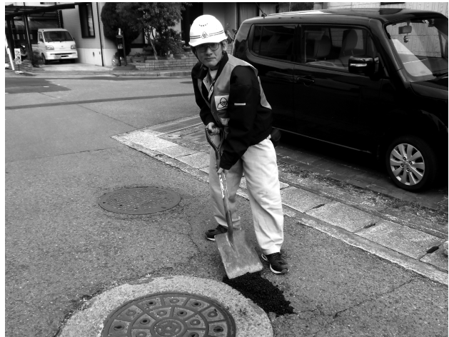
常温合材による陥没補修（私）
