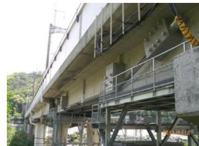
図-6 外ケーブル張力モニタリングシステムの設置状況
