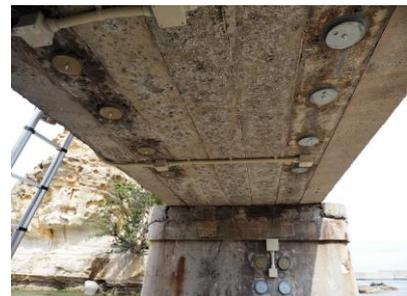
図-5 Zn カートリッジを用いた流電陽極材の設置状況
