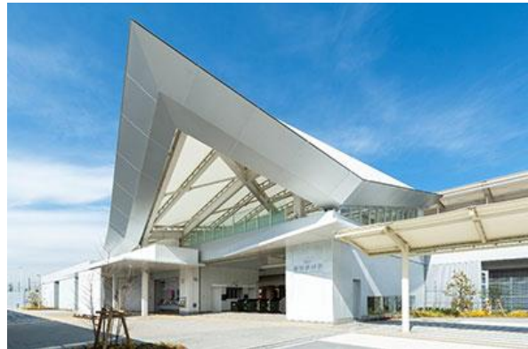
写真-1 駅舎外観
