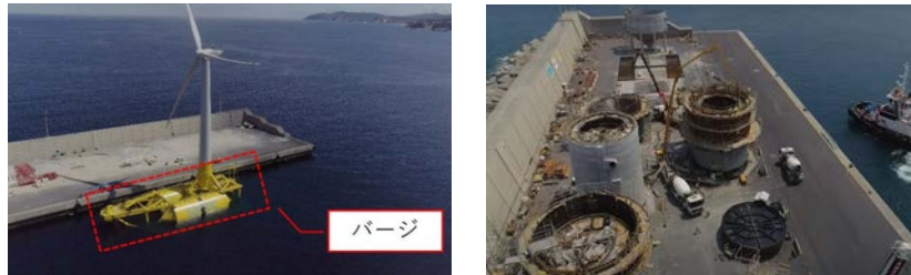
左：DemoSATH 浮体（ビルバオ港） / 右：浮体建設時写真（Saitec Youtube 動画抜粋）
