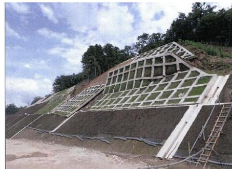
写真-1 地すべりにより破損した施工間もない構造物
