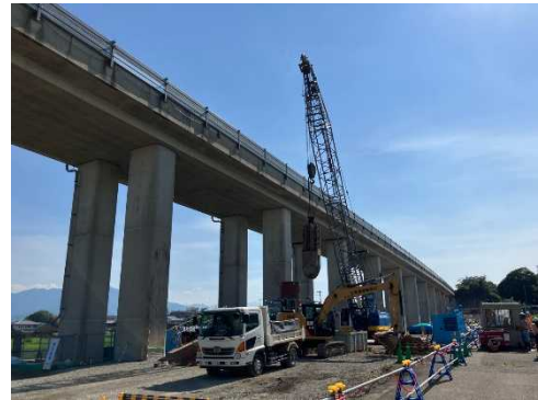
場所打ち杭 掘削状況
