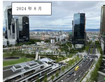
うめきた 2 期地区の工事状況
