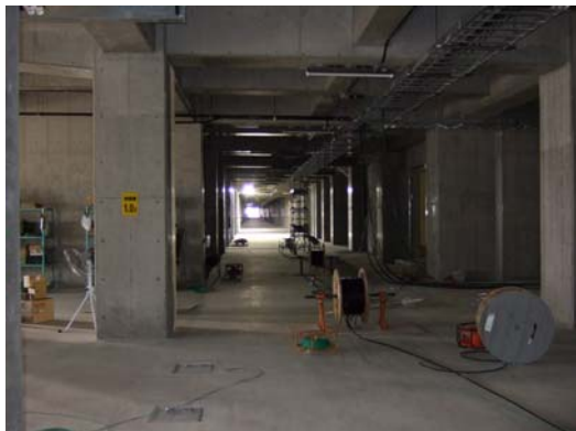
■ 建設中の水処理施設内部
