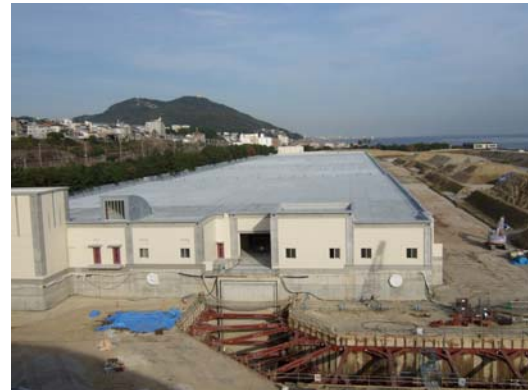
■ 垂水処理場第3期拡張工事全景
