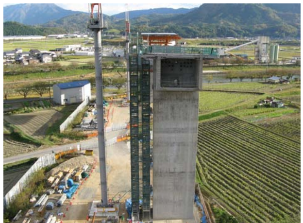
◆ 橋脚と柱頭部
