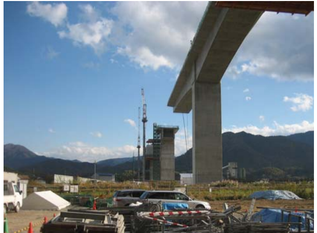
◆ 起点部現場状況
