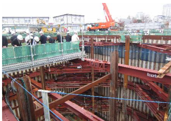
写-3 高段ポンプ棟工事現場
