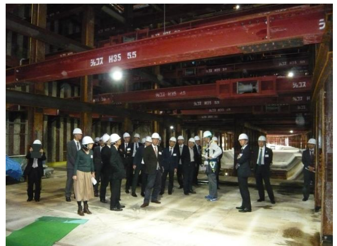
写真-4 工事現場の見学風景
