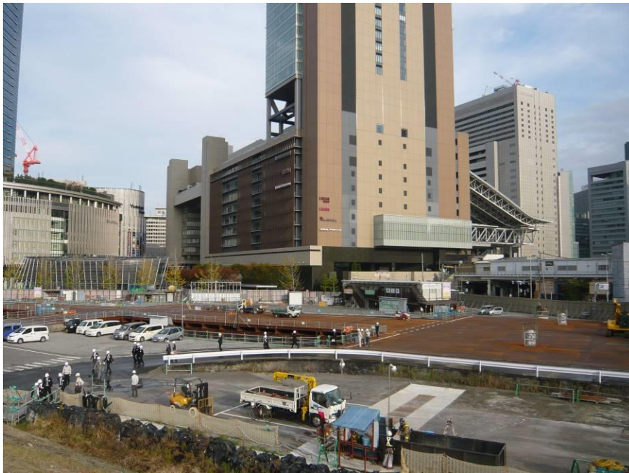
写真-1 工事現場遠景
