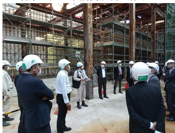
開削トンネル工事現場の様子
