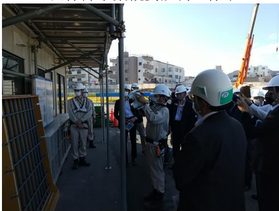
3 眼カメラ配筋検査システムデモの様子
